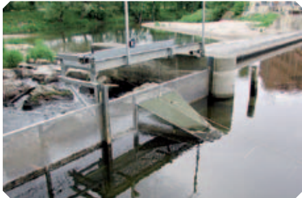
Steigaalfangreuse am Fischpass Jonitzer Mühle (Foto: Fladung)
