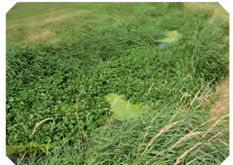
Unterhalb Ristedts - ausgebaut-zugewachsen
