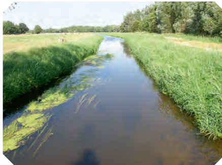
Unterhalb Beetzendorf - ausgebaut-Trapezprofil
